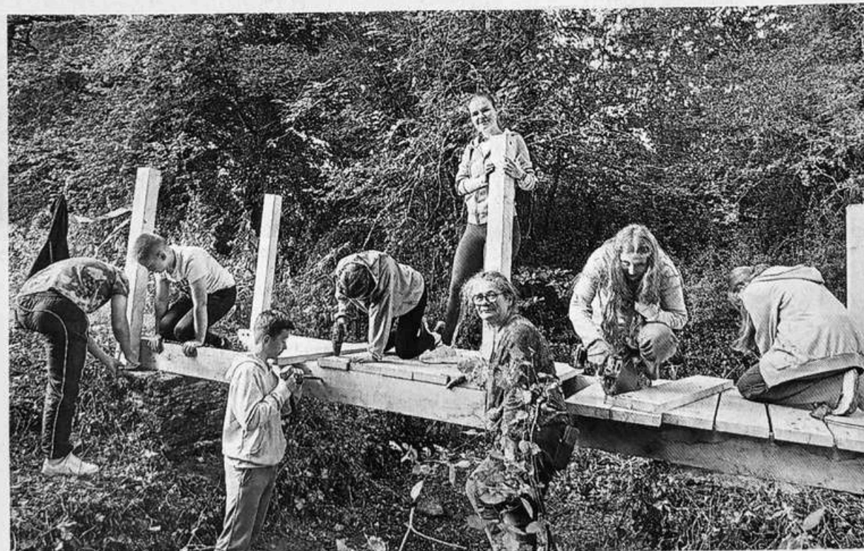
Un des groupes de jeunes lors de la construction d'une nouvelle passerelle.
